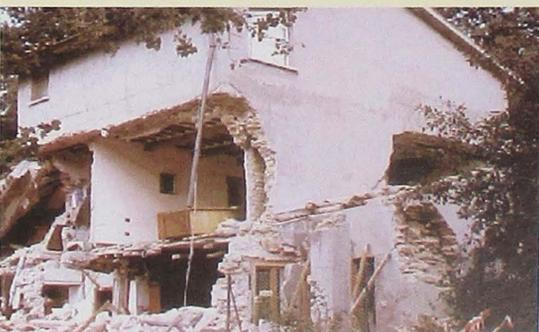
Ribaltamento della facciata in un edificio con solaio ligneo
